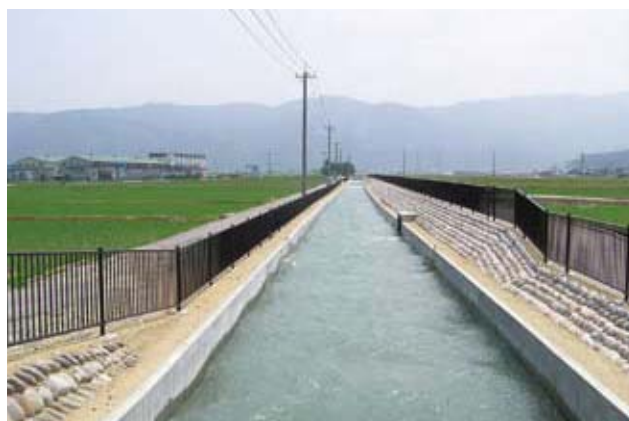
幹線水路（能美市宮竹町地内）
