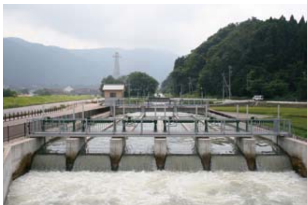
沈砂池（能美市岩本町地内）
