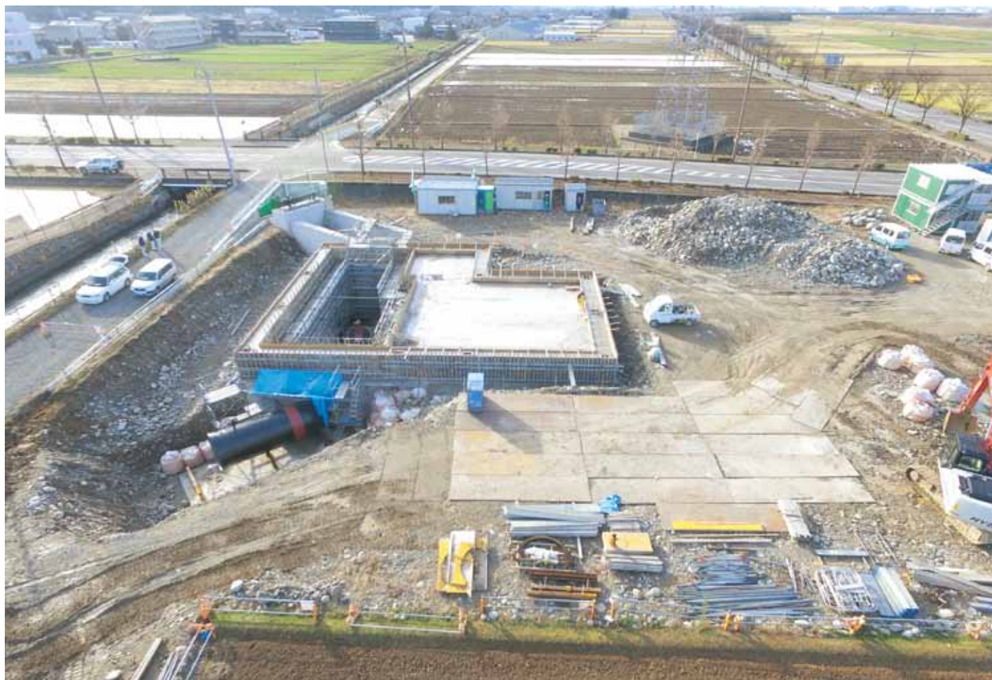
工事が進む宮竹用水第二発電所（能美市宮竹町地内）
