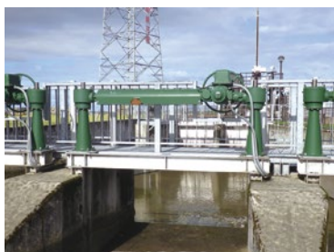
沈砂池排砂水門
