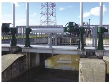
三反田水門（取入水門）転落防止柵
