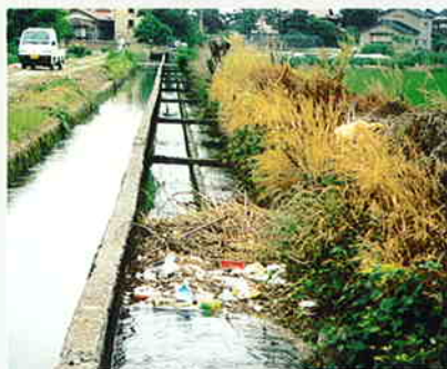
小松市高堂町地内河原用水路
